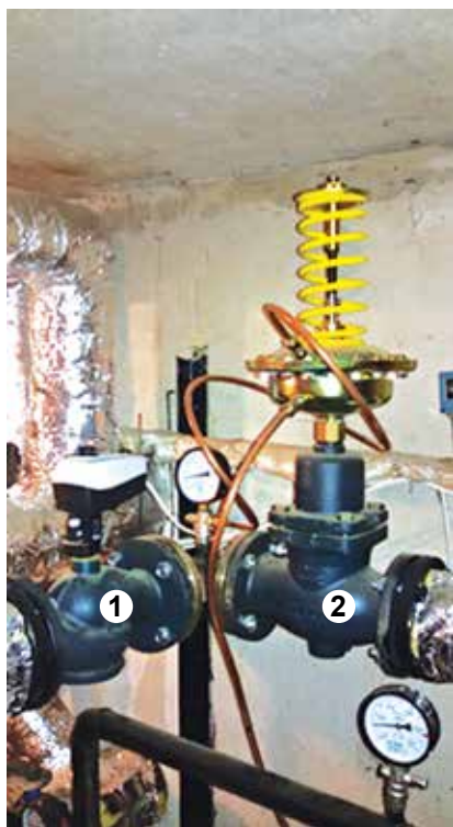
Рис. 5.4. Регулювальний клапан з електроприводом (1) та регулятор перепаду тиску (2)
