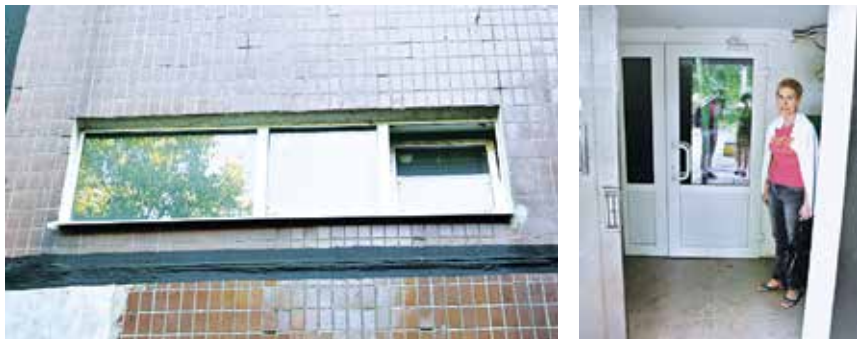
Рис. 7.10. Заміна вікон та облаштування тамбурів
