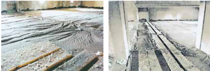
Рис. 7.9. Утеплення технічного поверху й облаштування проходів
