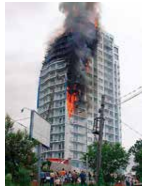
Рис. 7.7. Можливі наслідки неякісного утеплення багатоквартирного будинку пінополістиролом
