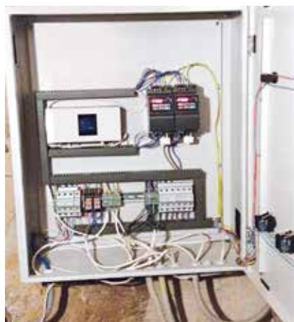
Рис. 5.7. Електронний регулятор температури в шафі управління
